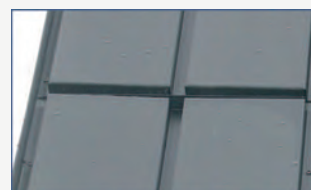
Chiusura elementi in testata
